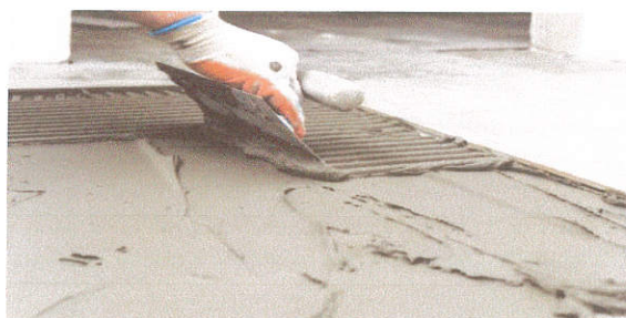
รูปภาพที่ 22 การใช้เกรียงหวีปาดกาวซีเมนต์
